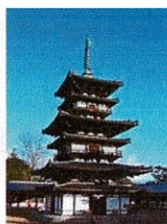
改装・再建された薬師寺東塔
